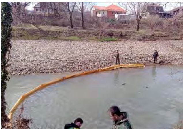
Рисунок 3 - Процесс установки заграждения
